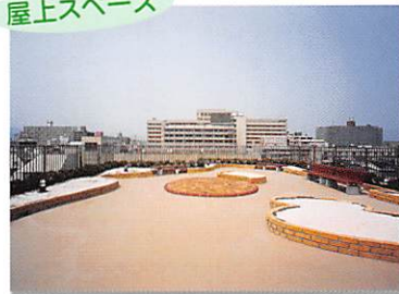
屋上スペース
